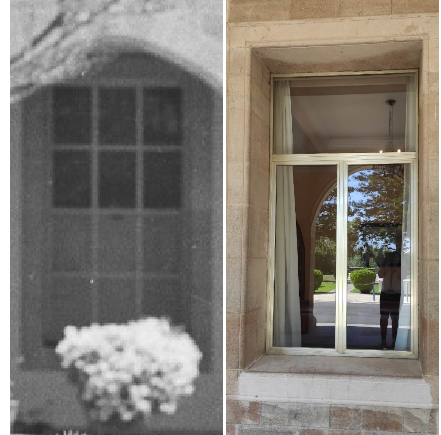
Κτίριο Προεδρικού πριν και μετά την αποκατάσταση
